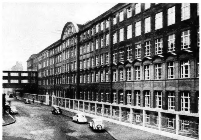
Das Wernerwerk 1 in Siemensstadt in seiner gegenwärtigen Form. Links der Übergang zum Wernerwerk-Hochbau
